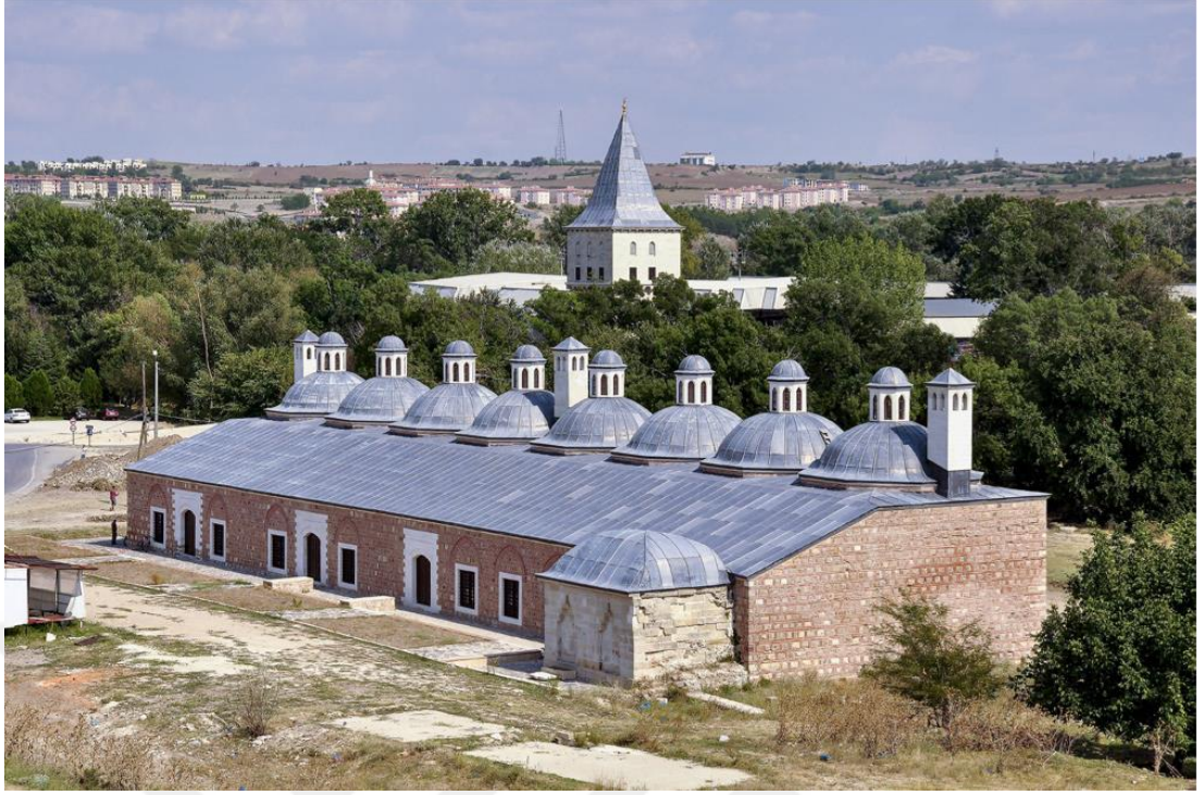
Görsel 2.3 Edirne Yeni Saray'daki saray mutfağının restorasyon sonrası (Özer M., 2023, s. 21).
