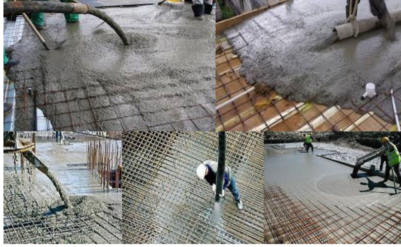
Şekil 2.1. KYB'nin yerleştirilmesi sırasında akışkanlık ve ayrışma direnci.
