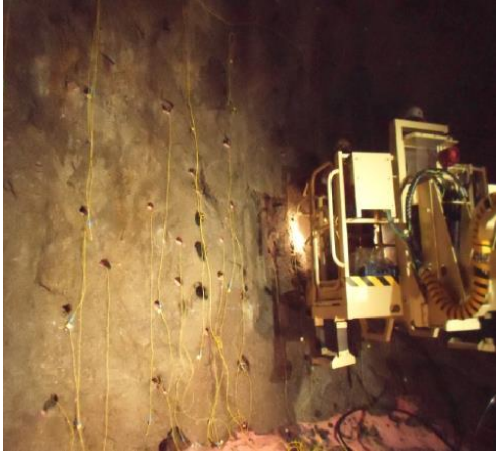
Şekil 3.11 Normet ile Ayna Dolumu
