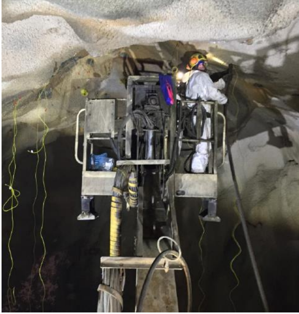
Şekil 3.13 Ateşçi Aracı ile Slot Dolumu
