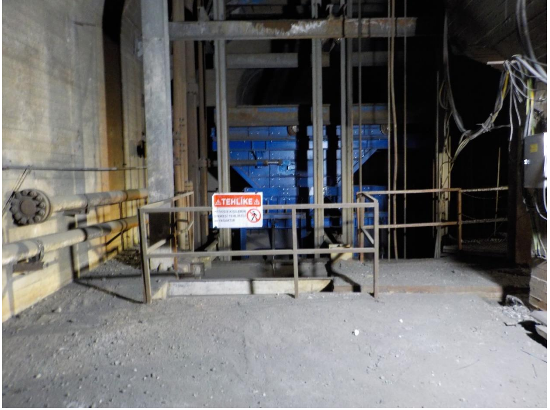
Şekil 3.19 Yeraltı Şaft İşlerinde Kullanılan Geçici Korkuluk
