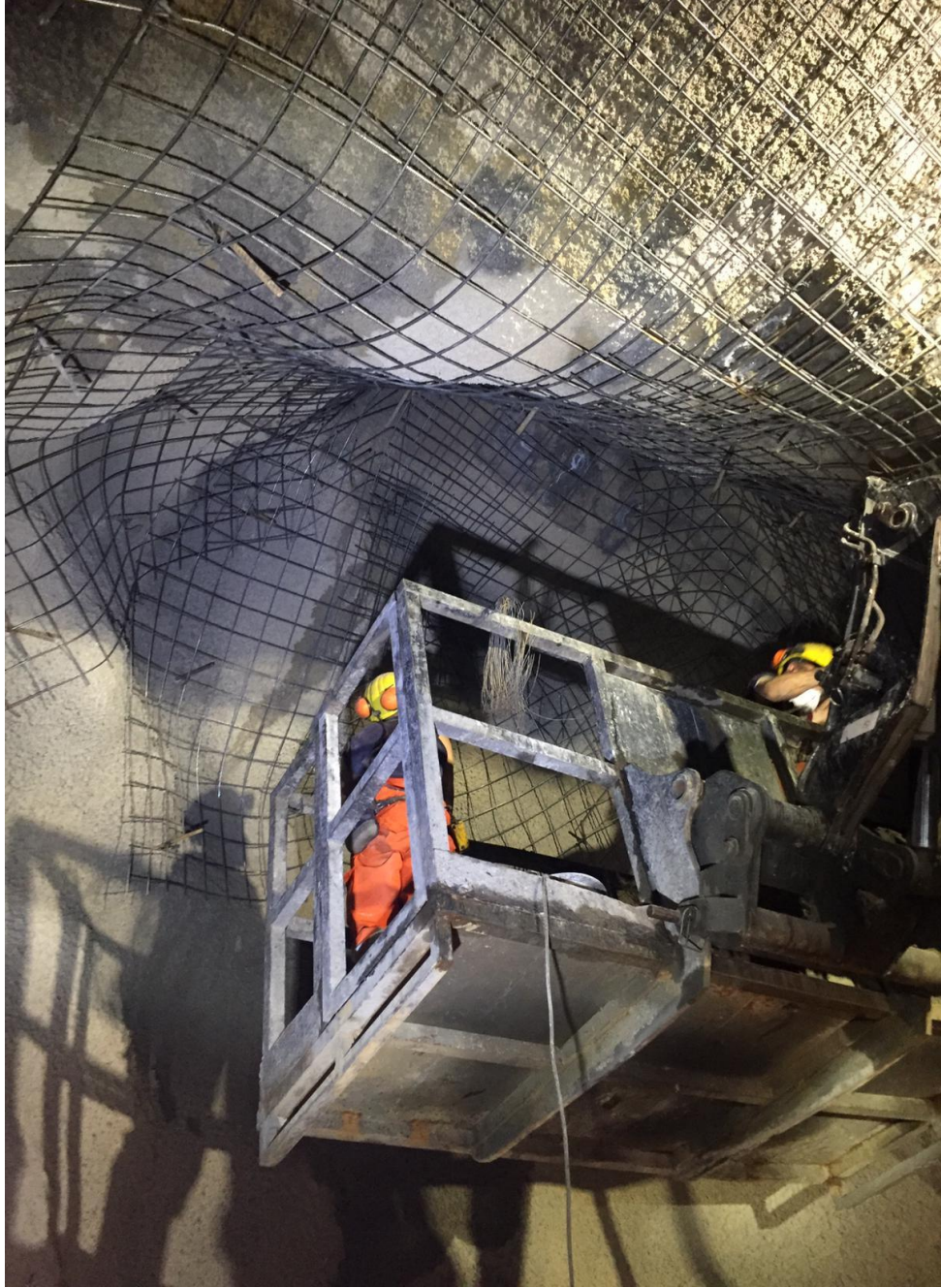
Şekil 3.12 Sehbanın Ulaşamadığı Yerde Tahkimat Yapımı
