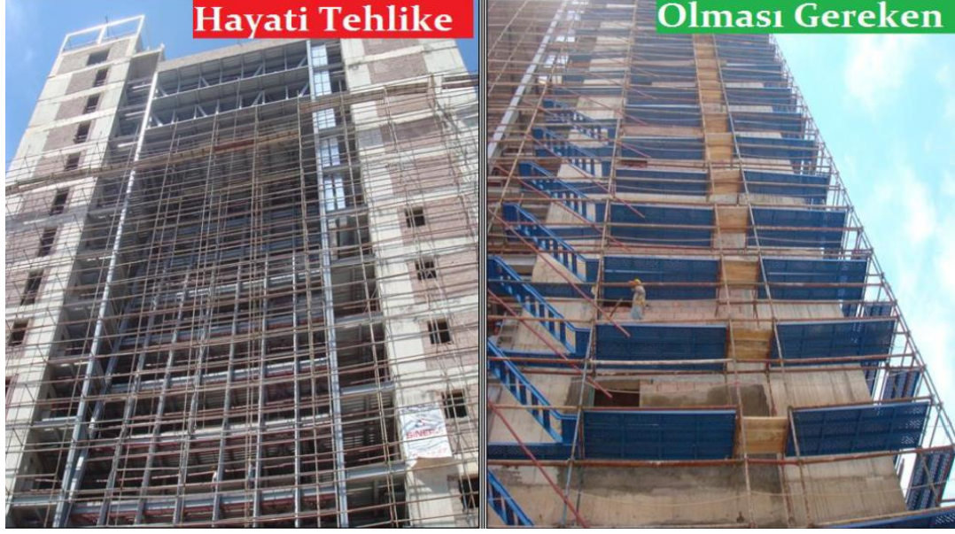
Şekil 3.20 Doğru ve Yanlış İskele Kurulumu
