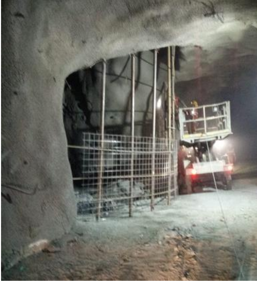
Şekil 3.16 Sehba Yardımı ile Barikat Yapımı
