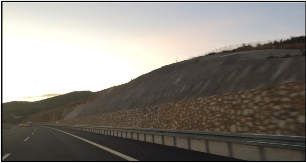
Fotoğraf 1.1. Farklı cansız materyallerle yamaç yüzeylerinin kaplanması
