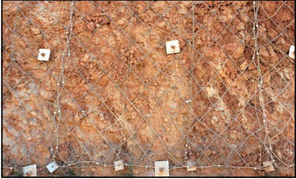
Fotoğraf 1.3. Ana kayanın kafesleme yöntemiyle stabil hale getirilmesi
