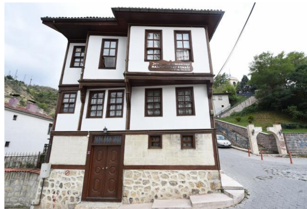
Resim 23. Mazlumcuoğlu Konağı (URL-40, 2017)
