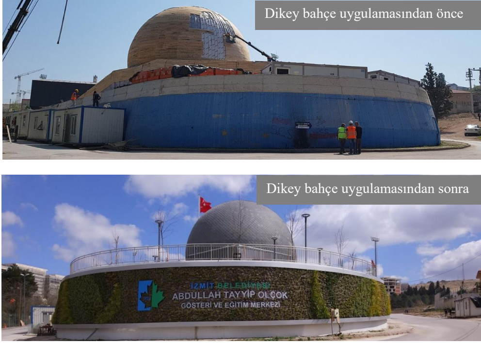
Şekil 4.10. 28 Haziran Mahallesi dikey bahçe uygulaması öncesi ve sonrası
