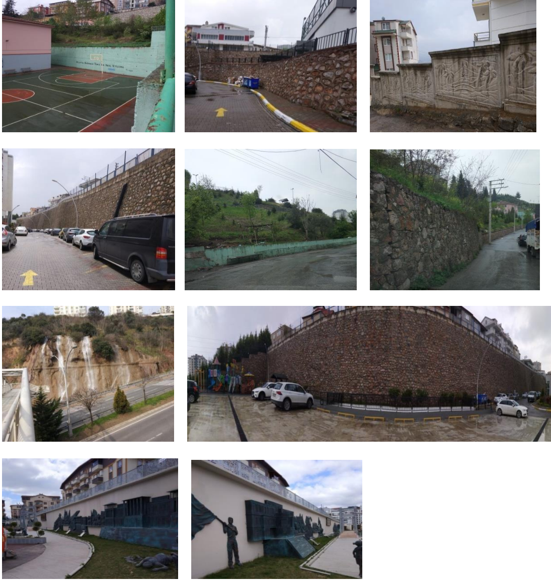
Şekil 4.16. Topçular Mahallesi'ndeki duvar örnekleri
