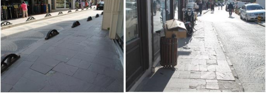
Şekil 4.7 Belediye caddesi yol ve kaldırım döşemeleri
