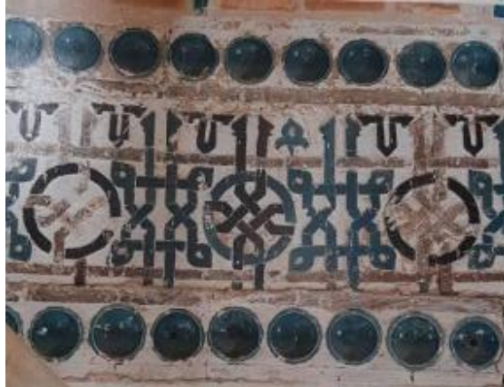
Şekil 3.37 Akşehir, Küçük Ayasofya Mescidi, kubbe eteği mozaik çini ve baçiniler (Arık ve Arık, 2007, s. 64)
