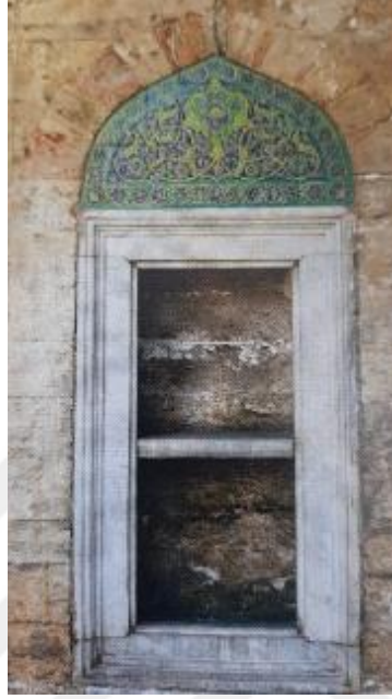
Şekil 4.29 İstanbul Kara Ahmet Paşa Cami son cemaat yeri dolap nişleri (Demirsar Arlı ve Altun, 2008, s. 177)
