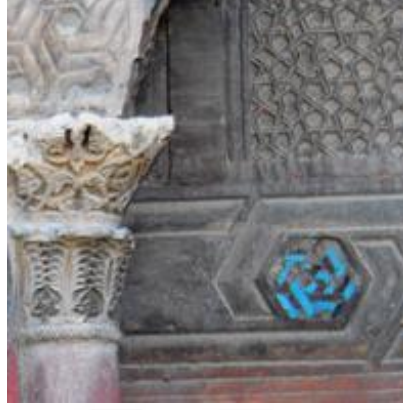
Şekil 3.17 Tokat Gök Medrese taç kapı taş kakma çini. (Cambaz, 2011)
