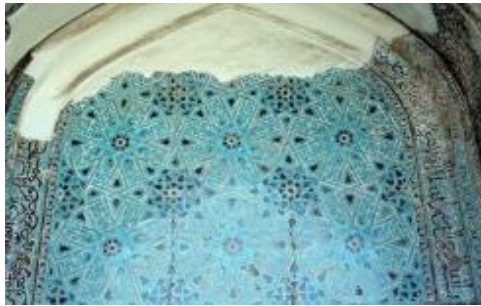
Şekil 4.116 Konya Sırçalı Medrese eyvan arka duvarı (URL-45, 2017)
