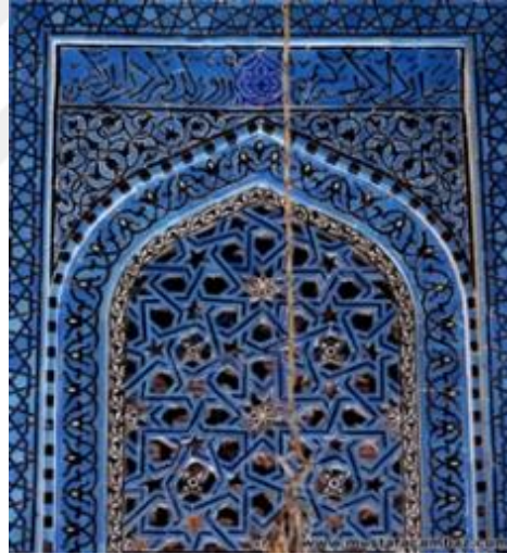
Şekil 4.143 Konya Sahip Ata Türbesi'nin, mozaik çinilerle kaplı pencere şebekesi (Cambaz, 2009)
