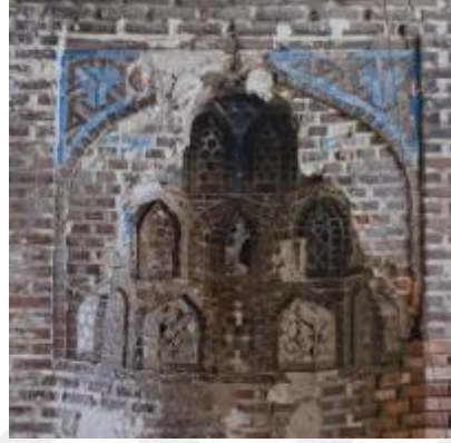
Şekil 4.25 Sivas, I. İzzettin Keykavus Şifahanesi kuzey eyvanı niş (Arık ve Arık, 2007, s. 53)
