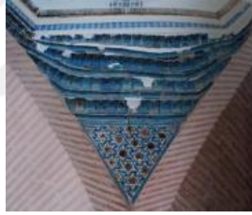
Şekil 4.56 Selçuk İsa Bey Camisi, köşe üçgeni (Arık ve Arık, 2007, s. 178)
