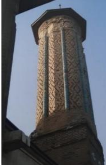
Şekil 4.39 Konya İnce Minareli medrese (Erdemir, 2015, s. 133)
