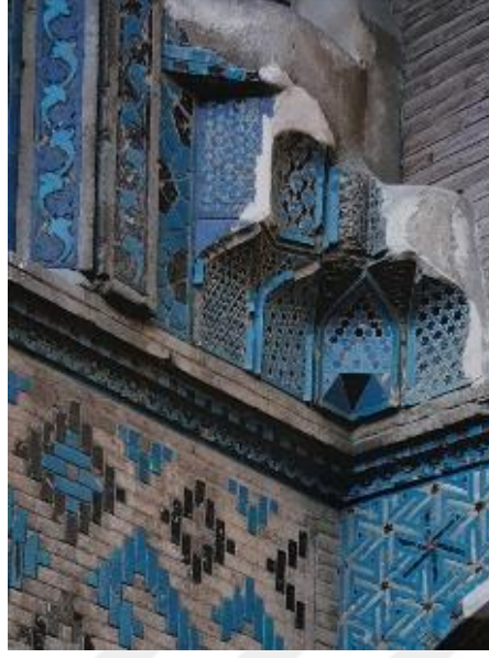
Şekil 4.57 Konya Sırçalı Medrese giriş eyvanı mukarnası (Arık ve Arık, 2007, s. 76)
