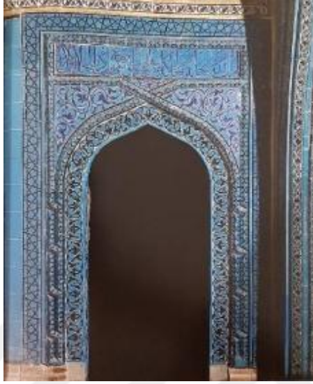
Şekil 4.148 Konya Sahip Ata Türbesi giriş iç yüzü (Arık ve Arık, 2007, s. 114)
