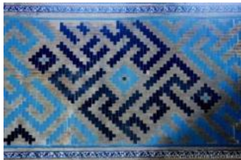
Şekil 4.118 Sahip Ata Türbesi'nin, çinilerle bezeli türbe içi ve sofa duvarından detay (Cambaz, 2009)
