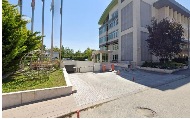
Şekil 4.4 Eser Yeşil Binası'ndaki bir binada yer altı otoparkı
