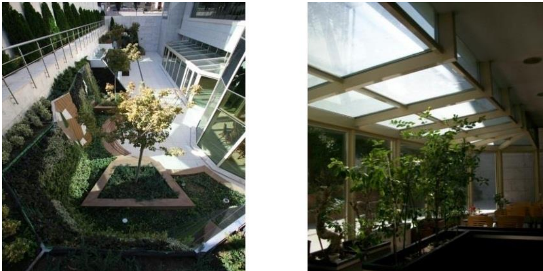
Şekil 4.16 Eser Yeşil Binasında kapalı bahçeler
