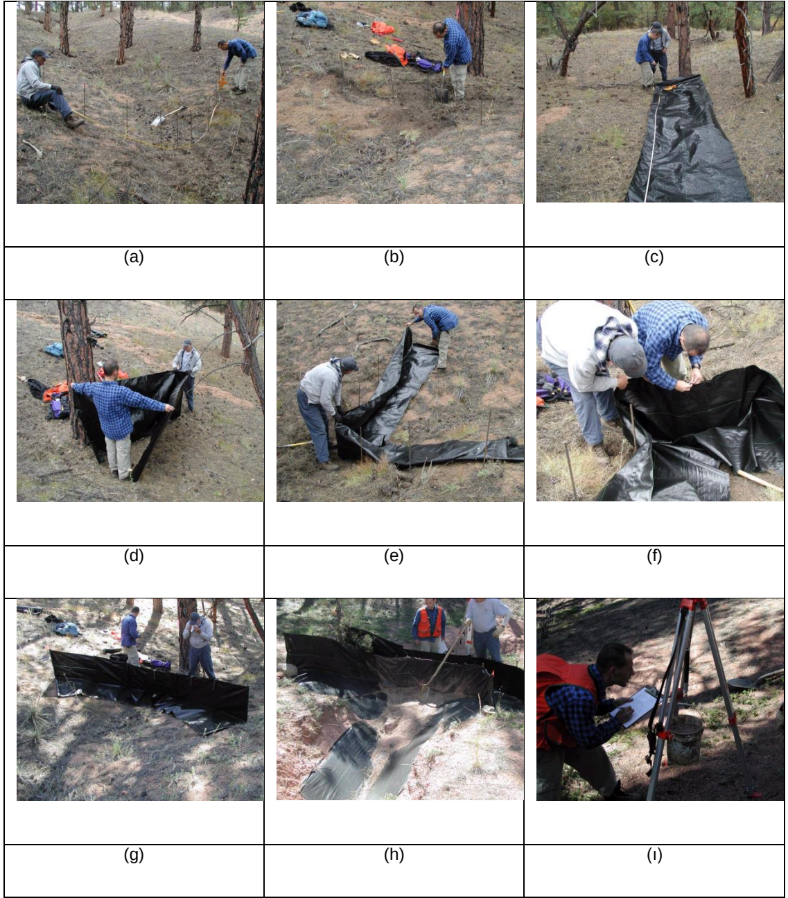
Fotoğraf 3.4. Sediment tuzağının kurulması (USFS)
