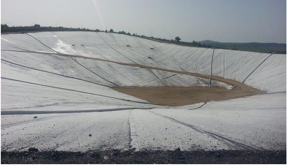
Şekil 3.1 Kastamonu düzenli depolama tesisinin işletmeye alınmadan önceki hali
