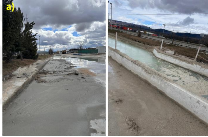
Şekil 3.5 Çökeltme havuzundan elde edilen beton çamuru
