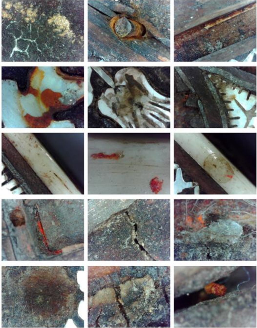
Resim 5.13 Çeşitli yüzeysel kalıntılar, toz ve kir birikintileri, eserin çıplak gözle tespit edilemeyen koruyucu uygulamaları, niteliksiz onarımlar sonucunda oluşan bozulmalar, mikro çatlaklar, çatlak ve kırıklara ait detay görüntüleri
