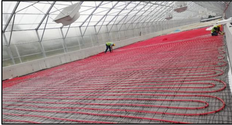
Şekil 3.6 Solar çamur kurutma ünitesi yerden ısıtma sistemi (Yazar tarafından oluşturulmuştur, 2021)
