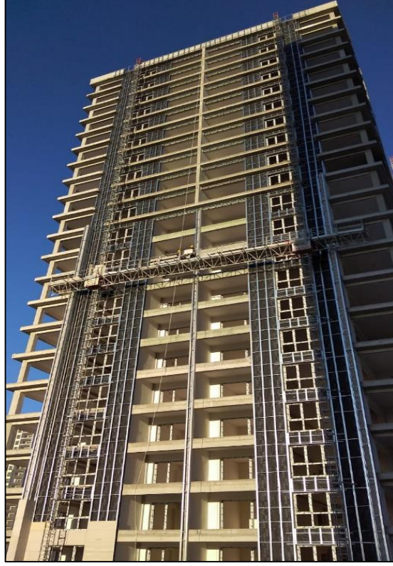
Şekil 4.3 Mevaşehir Eryaman, montaj işlemi yapılırken cephe görünüşü
