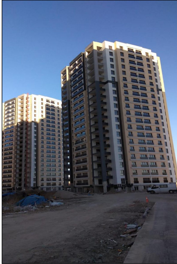
Şekil 4.4 Mevaşehir Eryaman, montaj işlemi tamamlandıktan sonra cephe görünüşü
