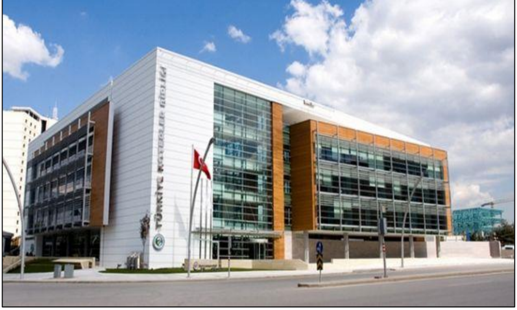
Şekil 4.7 Türkiye Noterler Birliği, montaj işlemi tamamlandıktan sonra cephe görünüşü
