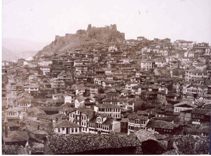
Şekil 3.3 Kale çevresindeki Kastamonu geleneksel evlerine ait görünüm (Sezer, 2010)
