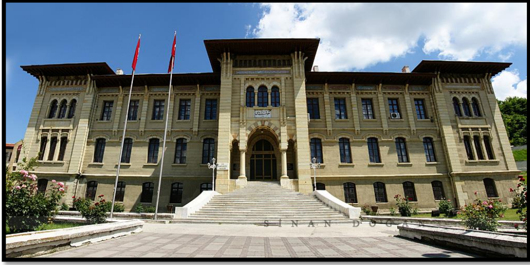
Şekil 3.51. Kastamonu Hükümet Konağı (Anonim, 2018)
