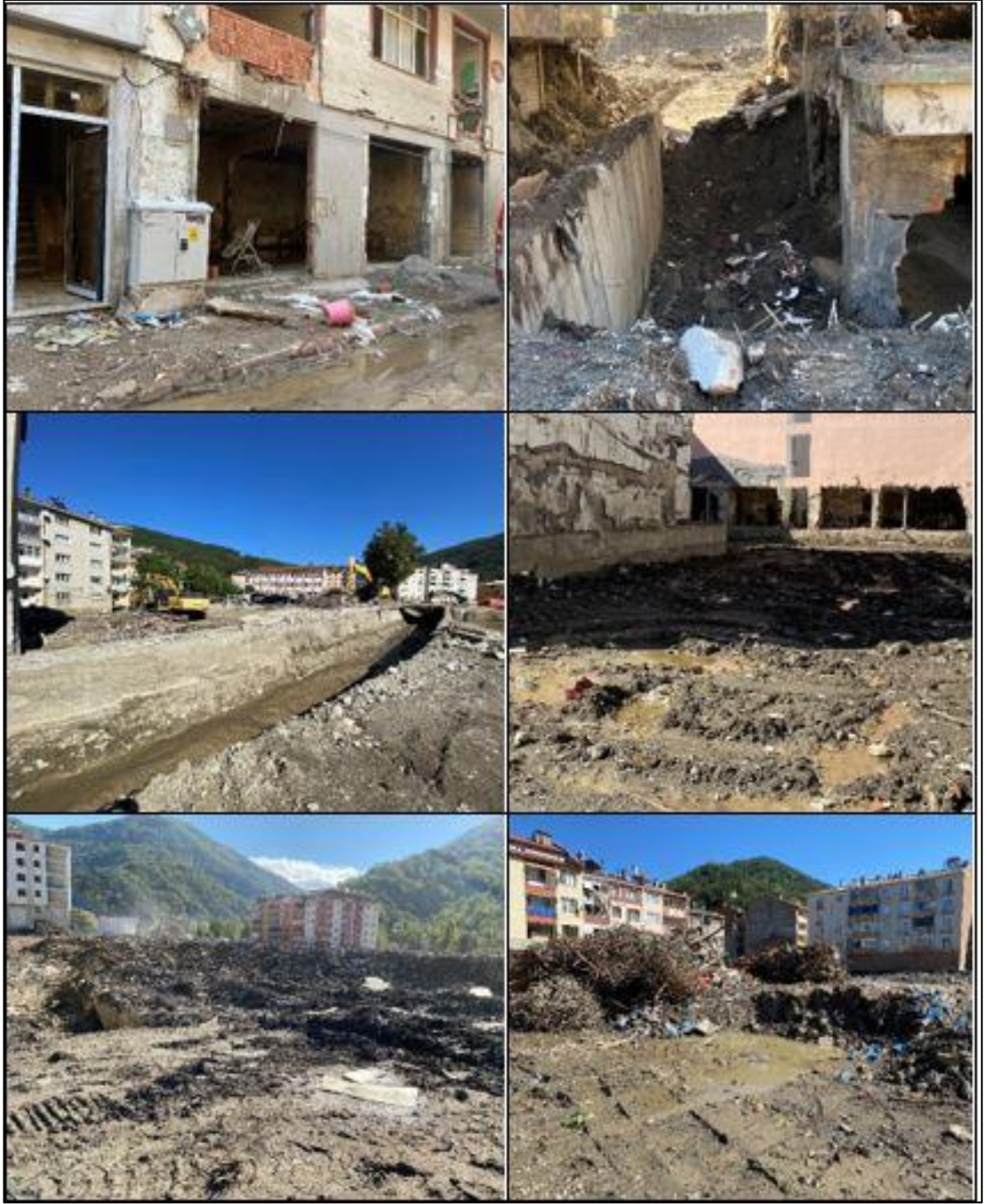
Şekil 2.23 Kastamonu- Bozkurt sel sonrası durumu II
