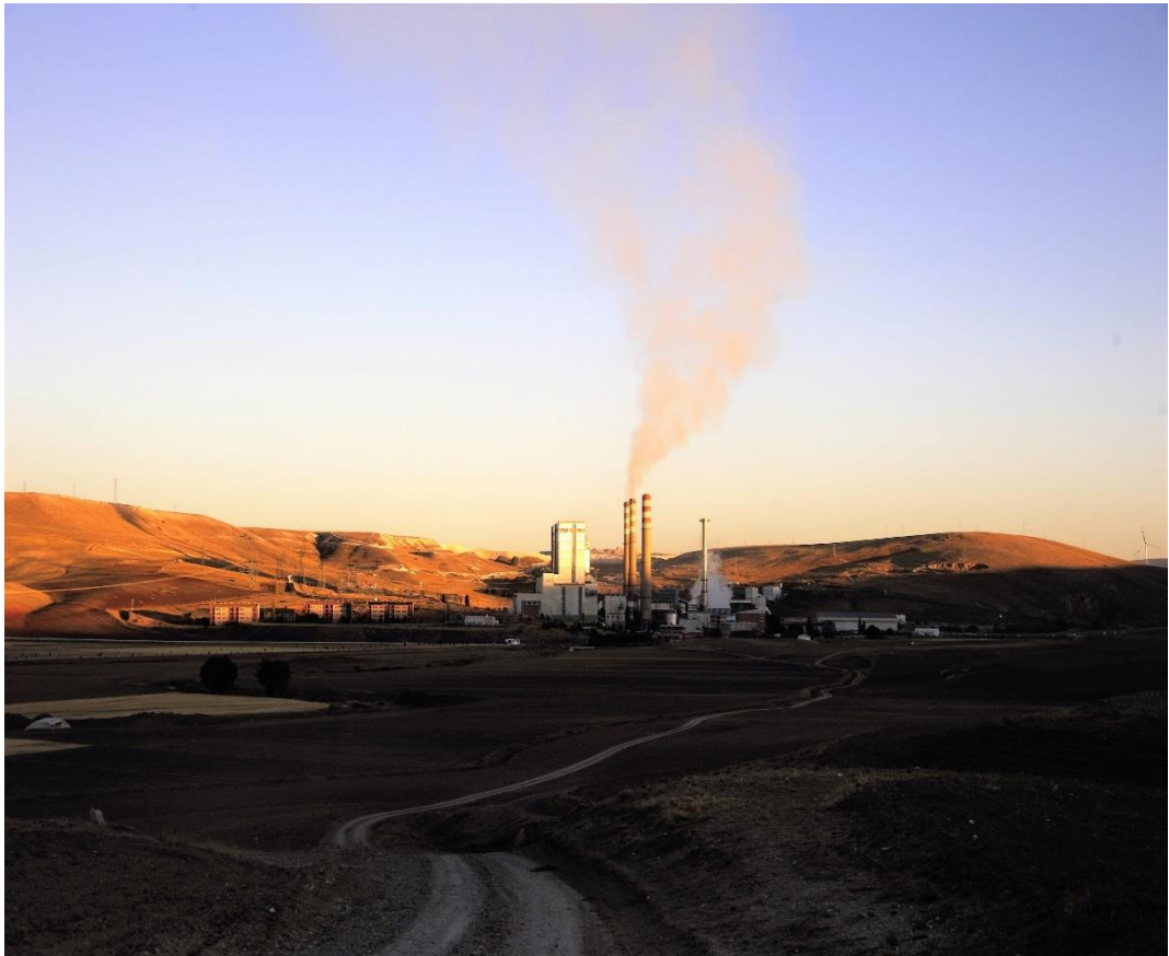
Fotoğraf 3.1. Kangal Termik Santralinin farklı açılardan görünümü
