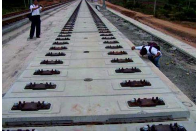
Şekil 2. 11 Demiryolu döşemesinde bazalt lif kullanımı (URL-3)
