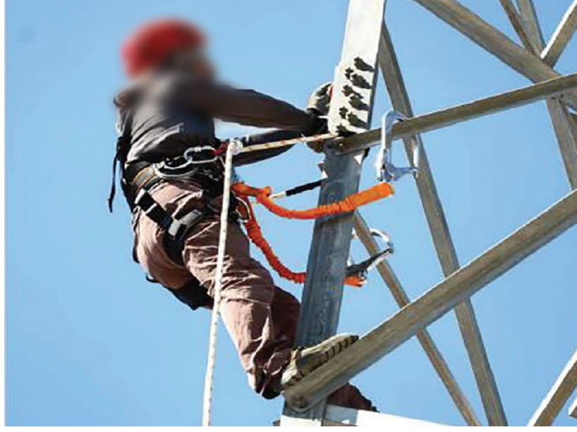
Şekil 4.22 Kafes tipi demir direklere iniş/çıkış
