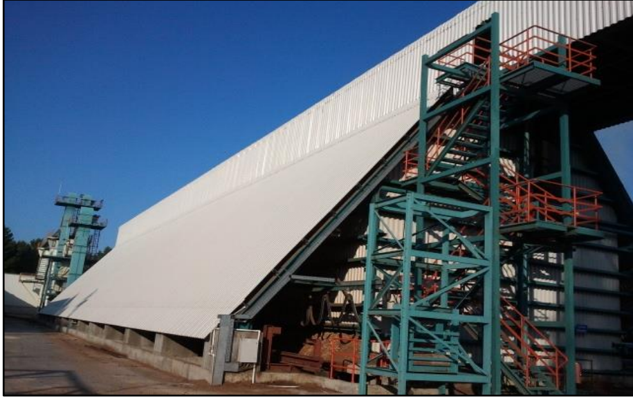
Fotoğraf 2.3. Chips siloları dış görünüş.
