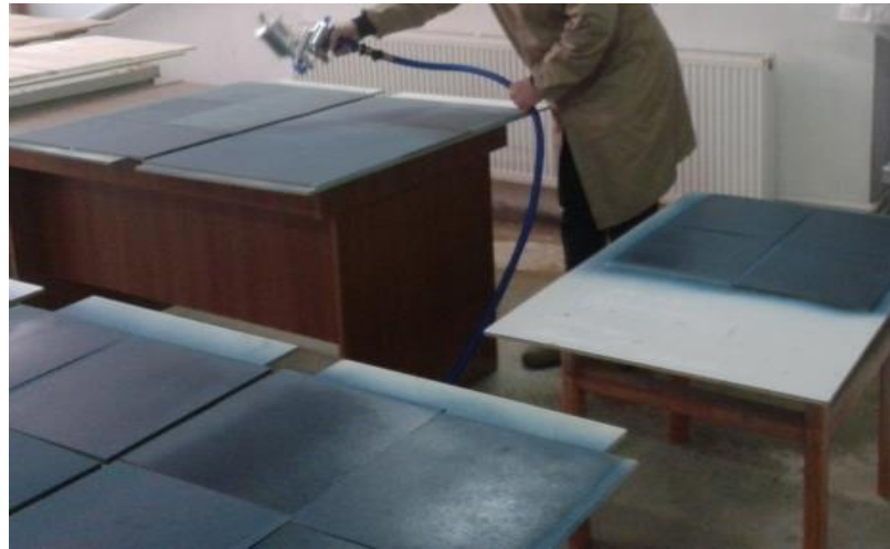
Fotoğraf 4.3. Su bazlı ısı yalıtım boyasının uygulaması
