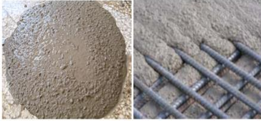
Şekil 2.5. Kendiliğinden yerleşen beton (Bostancı, 2014)
