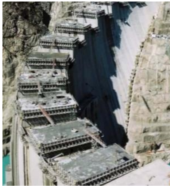
Şekil 2.2. Bir kemer baraj kütle betonu (Bostancı, 2014)
