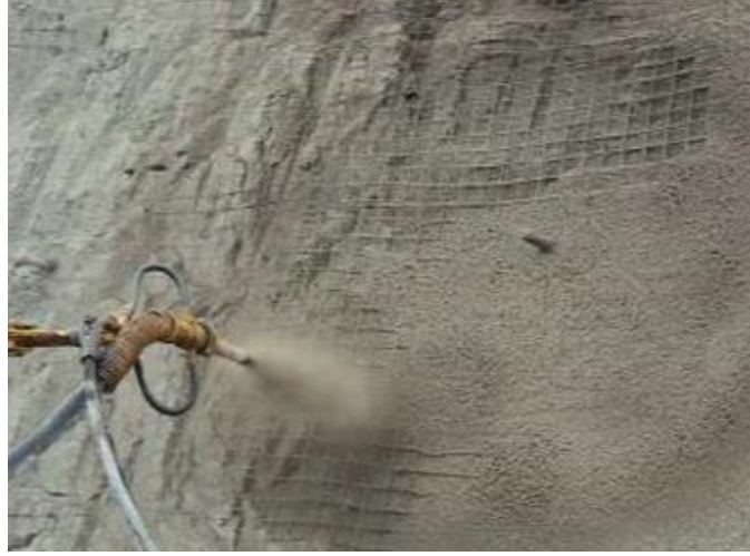
Şekil 2.4. Püskürtme beton uygulaması (Bostancı, 2014)
